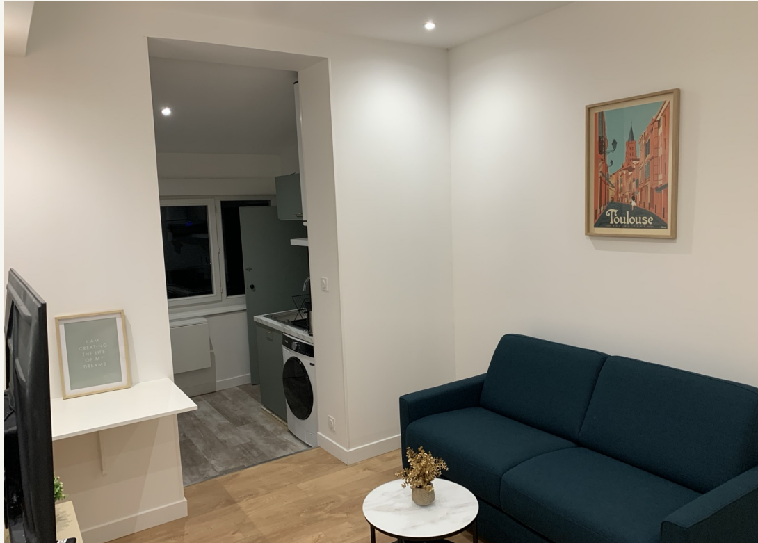
Rénovation du studio en plaques de plâtre.
