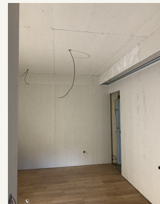
Création de la corniche avec spots intégrés.
