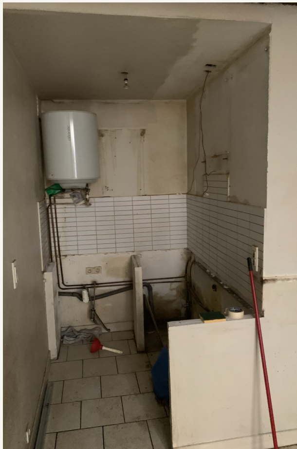
PENDANT LES TRAVAUX
