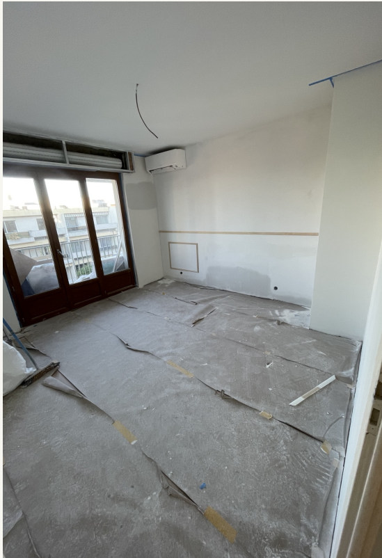
PENDANT LES TRAVAUX
