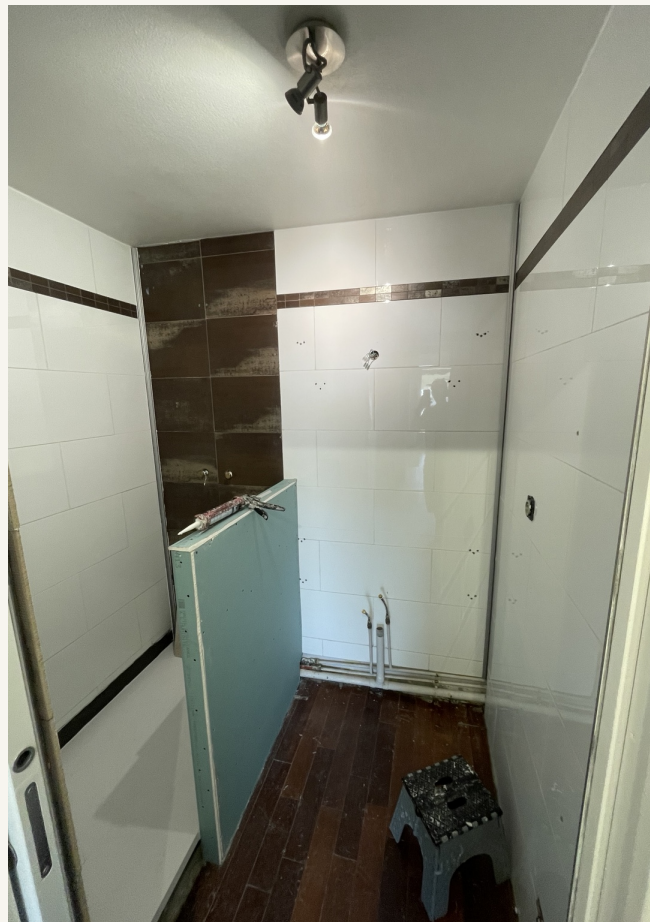
PENDANT LES TRAVAUX
